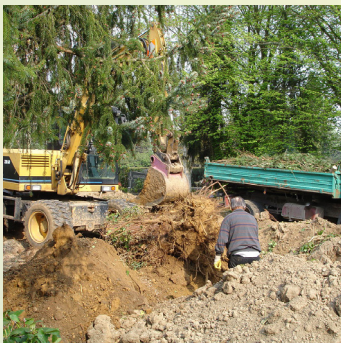
Erdarbeiten mit Baumfällung und Wurzelrodung
