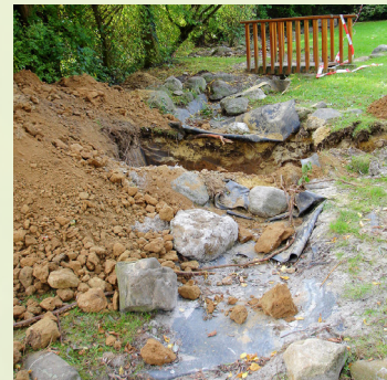
Anlegen eines Bachlaufs im Hang
