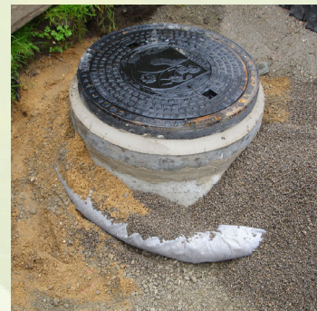
Einbau von Regenwasser-Zisternen
